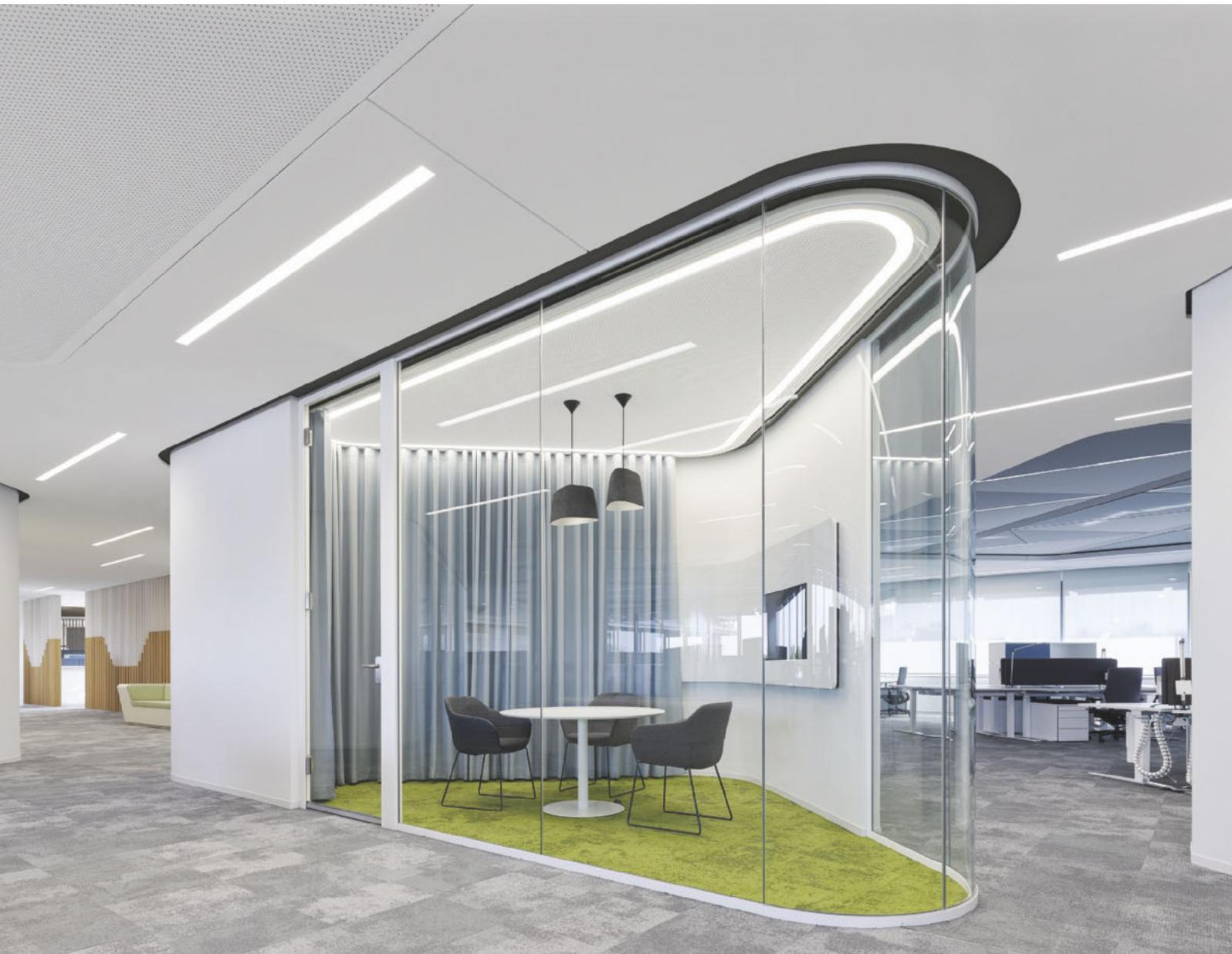
**Besprechungsinseln:** Das umlaufende Lichtband trennt eine Kühl- und Lüftungsdecke thermisch vom übrigen Trockenbau
